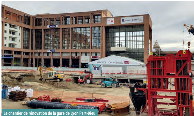
Le chantier de rénovation de la gare de Lyon Part-Dieu
